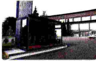
Impianto geotermico pilota a servizio del Technical Museum Nicolas Tesla di Zagabria
