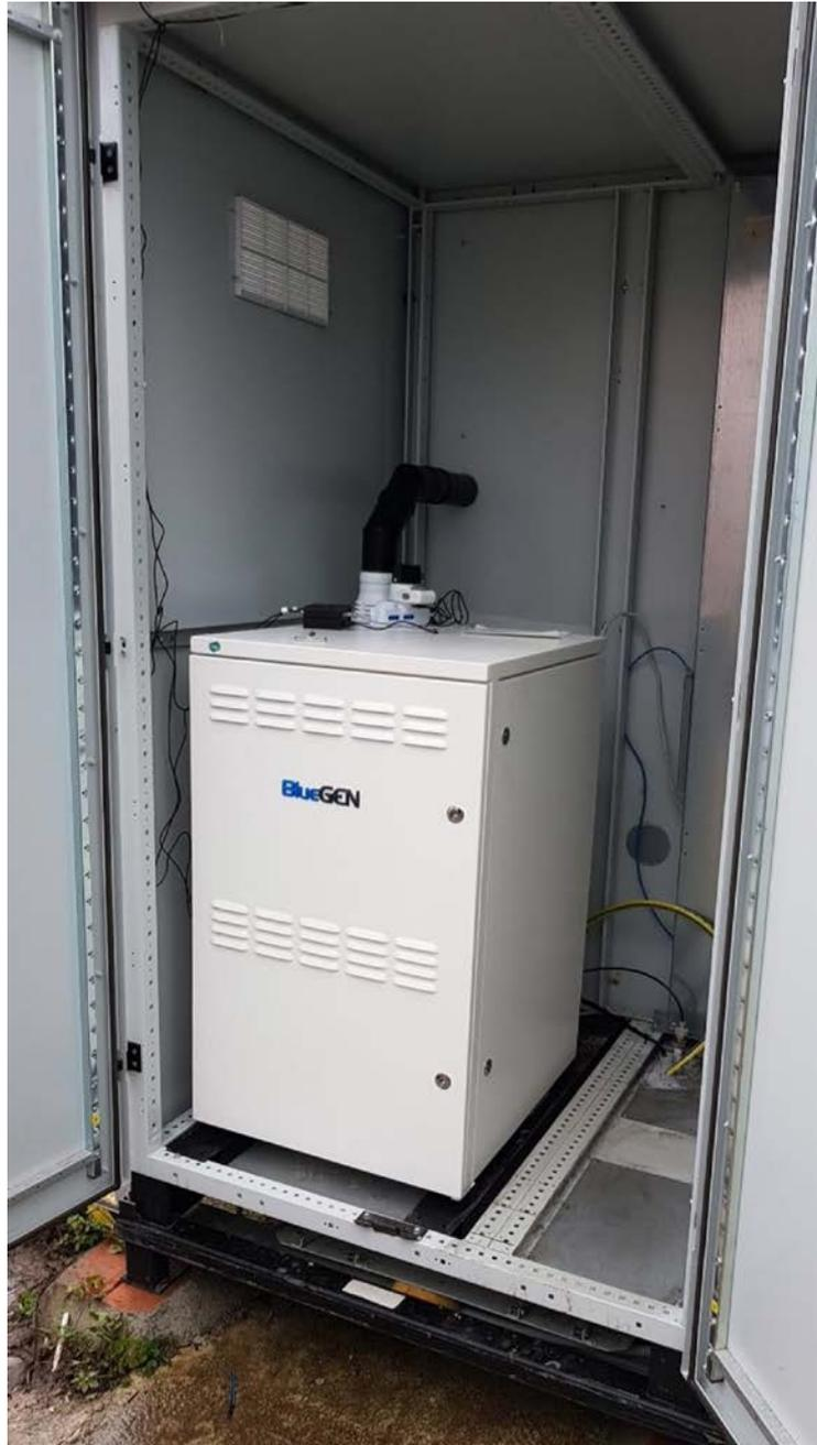
Il generatore SOFC "BLUEGEN" installato all'interno del cabinet presso il sito dimostrativo
