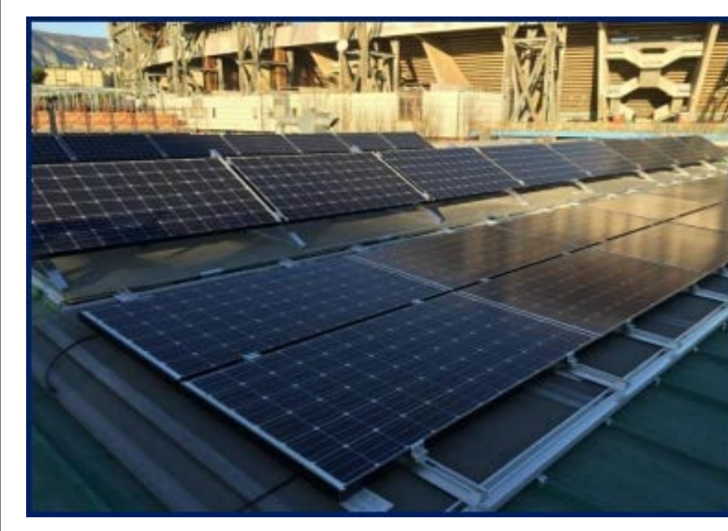
Impianto Fotovoltaico allestito presso il CNR – Istituto Motori
