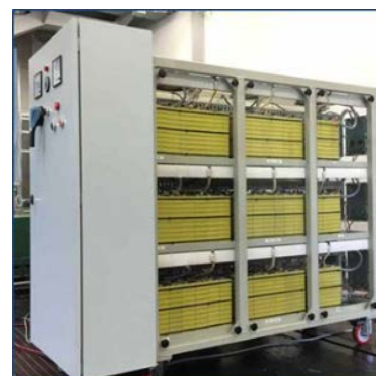
Sistema di Accumulo Stazionario allestito presso il CNR – Istituto Motori
