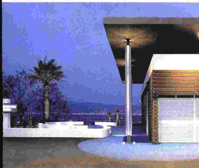
STAZIONE SPERIMENTALE RIFORNIMENTO IDROGENO PRESSO IL Cnr ITAE DI MESSINA
