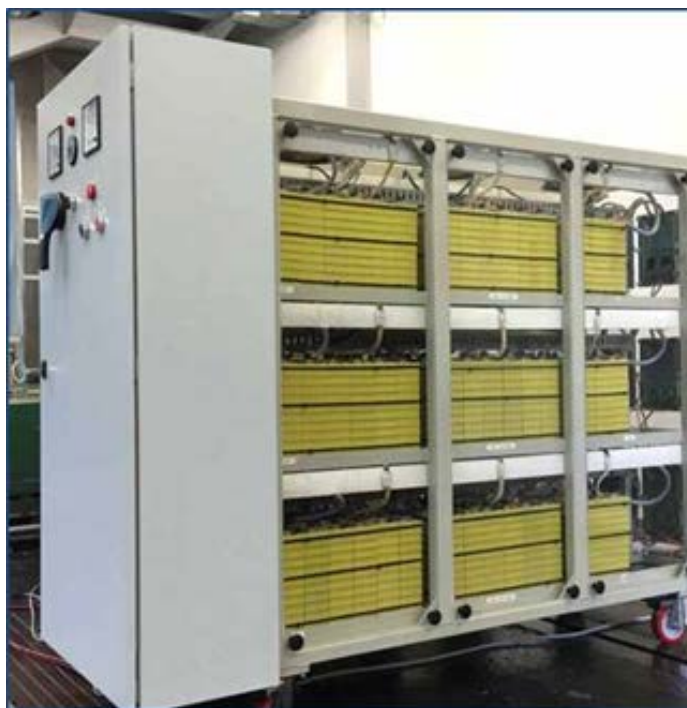
Fig. 2.2.21. Sistema di Accumulo Stazionario allestito presso il CNR – Istituto Motori
