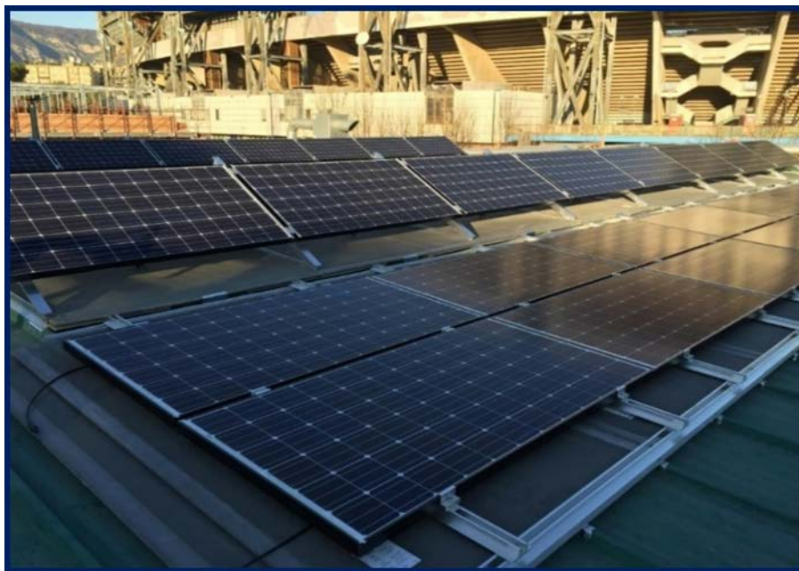
Fig. 2.2.26. Impianto Fotovoltaico allestito presso il CNR – Istituto Motori
