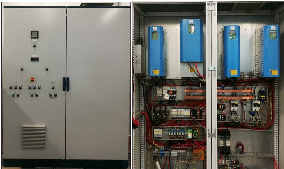
Fig. 2.2.13. Immagine esterna ed interna del quadro che integra il dimostratore di micro-grid.
