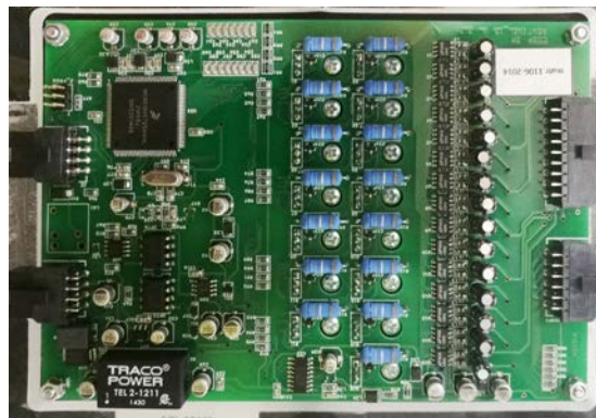
Fig. 2.2.18. Immagine di una delle unità slave connessa al BMS.
