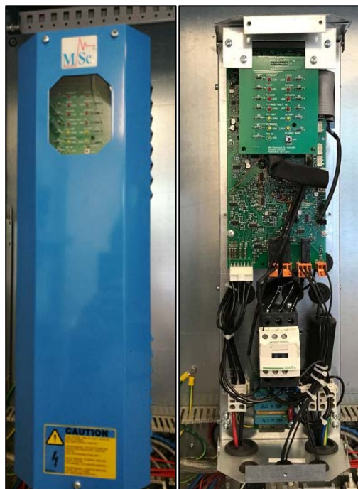
Fig. 2.2.10. Immagine esterna ed interna del convertitore AC/DC installato presso il CNR Istituto Motori.
