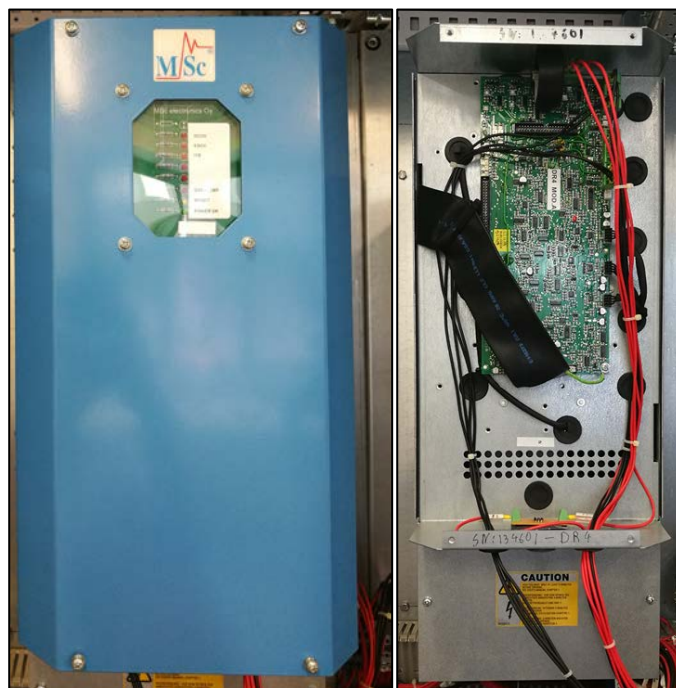
Fig. 2.2.12 Immagine esterna ed interna del convertitore DC/DC bidirezionale installato presso il CNR Istituto Motori.
