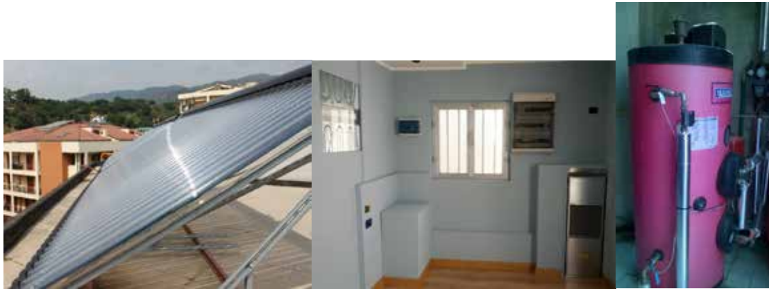
Figura 2: viste dell'impianto solar cooling installato presso l' ITAE: (da sinistra) il campo solare termico, l'interno dell'ufficio/dimostratore, l'accumulo termico.
