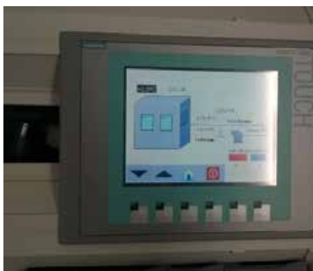
Figura 3: PLC installato nell'impianto di solar cooling.
